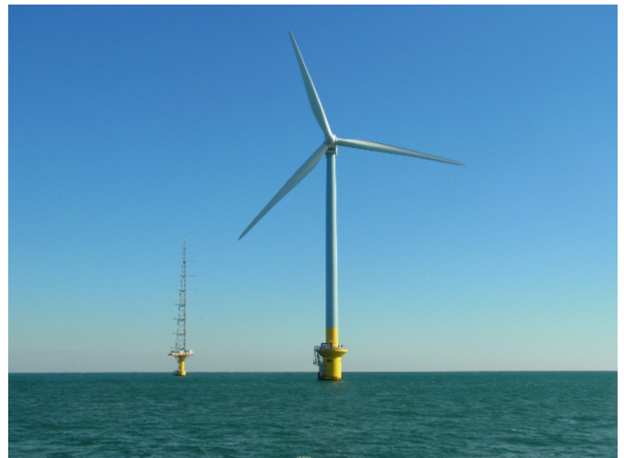
千葉県銚子沖洋上風力発電 出典：資源エネルギー庁
