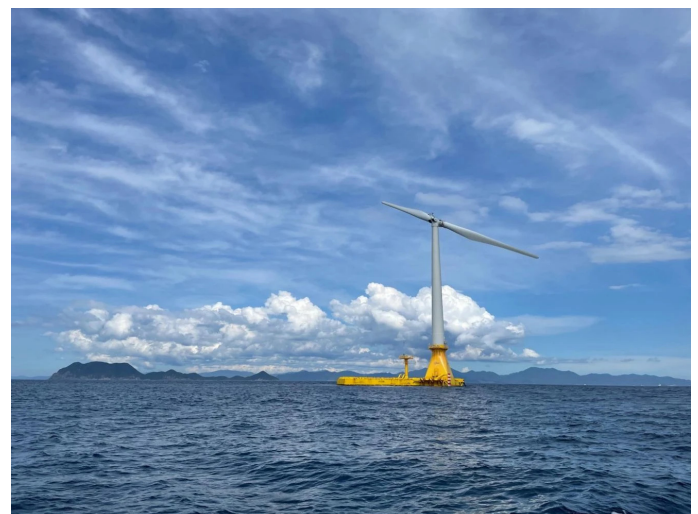
北九州にある浮体式洋上発電（竹内准教授撮影）
